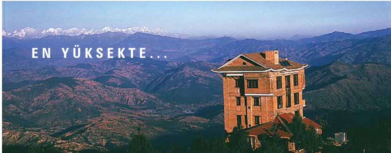
Fort Resort Oteli / Nepal Yüksek rakımda çalışmaya uygun Dizel Jeneratör Seti
