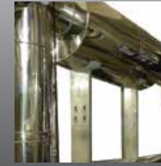
Manifold Isı İzolasyonu
